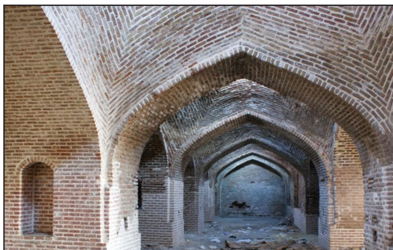
شکل شماره ۹: بخاری های دیواری و طاق های کاروانسرای نیک پی (عکس از نوراللهی)
