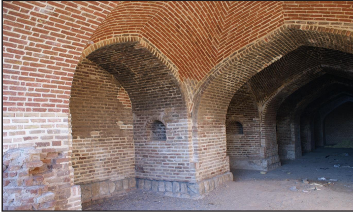
شکل شماره ۶: نمای اصطبل کاروانسرای نیک‌پی (عکس از نوراللهی)
